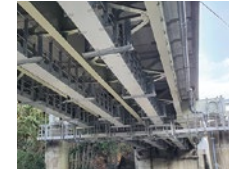
主桁・床版一体型FRP検査路
