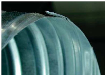
図12 ハゼ Fig. 12 Lock seam
