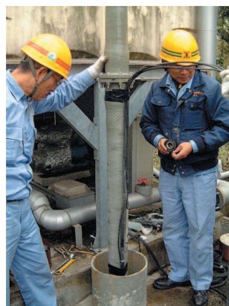
図8 順次挿入状況
