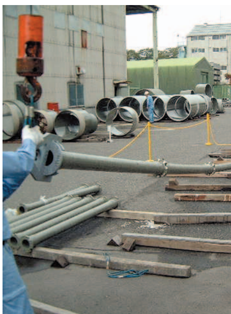
図5 吊り上げ状況
