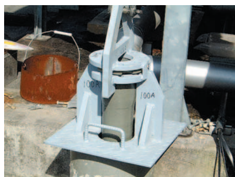
図6 専用吊り上げ治具使用状況
