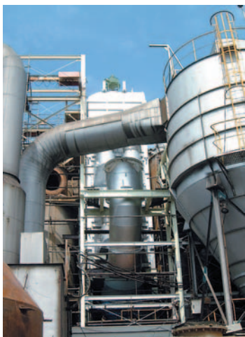
図8 新型空気予熱器 Fig. 8 New recuperator
