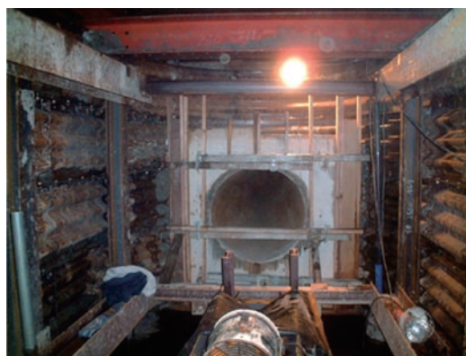
図6 立坑内挿入口：鋼管挿入前 Fig.6 Pithead
