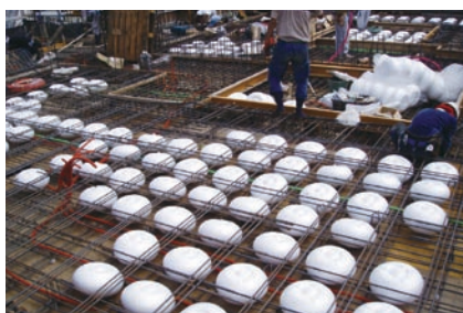
ボイド型枠の据付け 3 →
