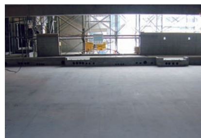
型枠脱型・養生
