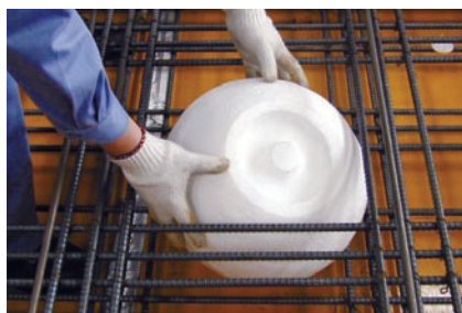
ボイド型枠の据付け 1 →
