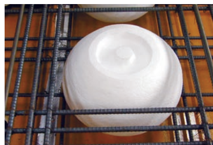
ボイド型枠の据付け 2 →
