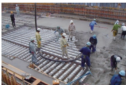
コンクリートの打ち込み →
