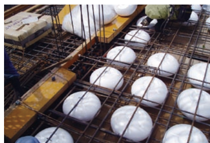
ボイド型枠の固定作業
