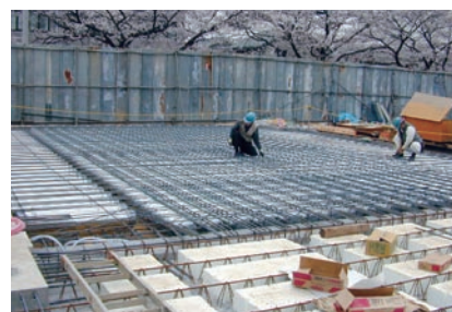
鉄筋工事(上端筋) →
