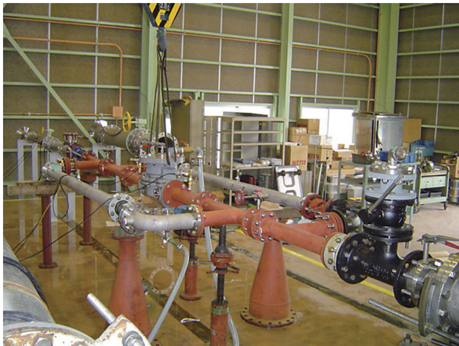
図7 試験状況写真
