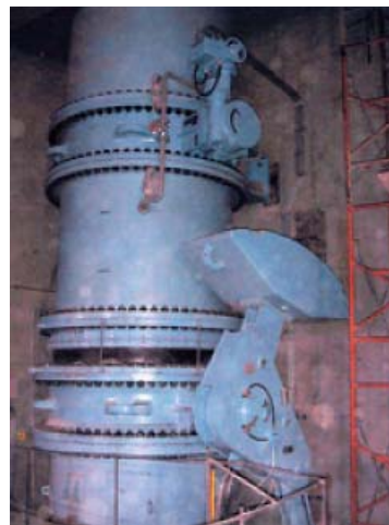
図18 \phi 2,400 カウンタウエイト付油圧式逆止バタフライ弁据付外観
