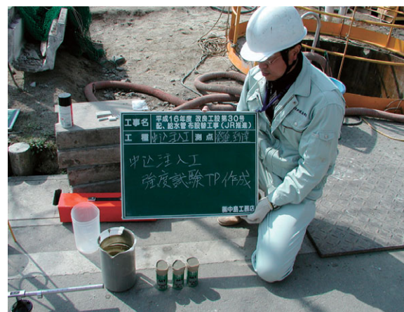
図22 強度試験供試体作成
