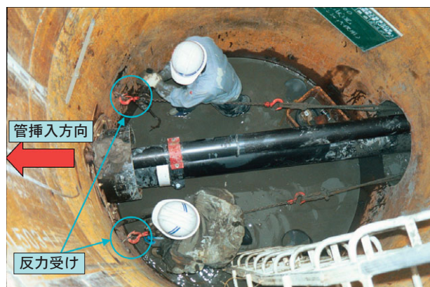
図10 管挿入状況
