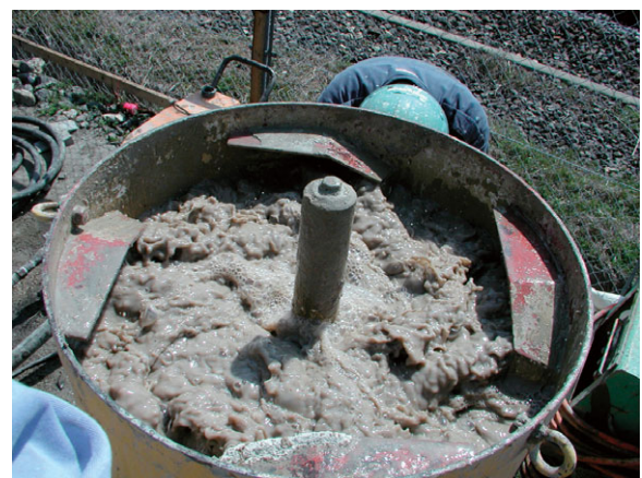
図18 流動化材スラリー混練状況
