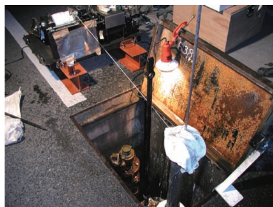
図9 実管路調査状況
