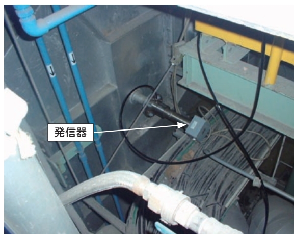
図3 赤外線レーザー式酸素濃度計溶融炉出口煙道部取付写真
