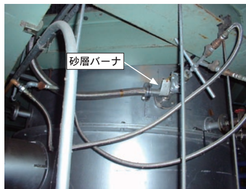
図14 ガス化炉砂層バーナ取付写真
