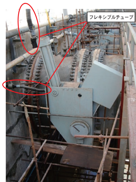
図7 シリンダ接続部写真(φ3,500)
