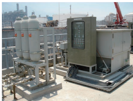
図9 油圧ユニット(φ1,800バタフライ弁)
