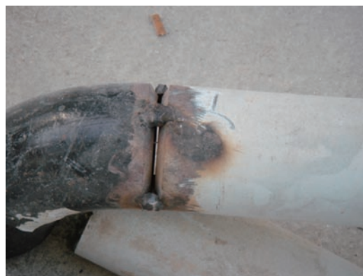
図5 油圧配管溶接写真(途中)
