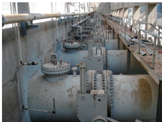
図4 油圧式逆止バタフライ弁据付け状況
