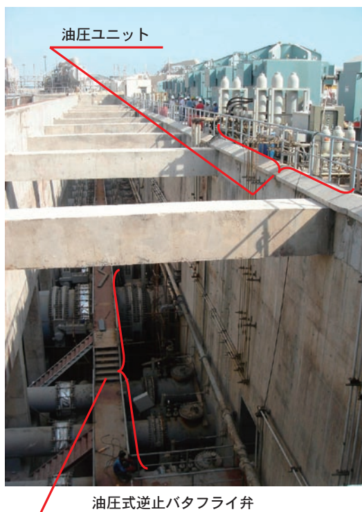
図3 機器据付け状況
