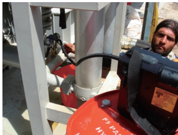
図8 フラッシング 清浄度確認状況写真
