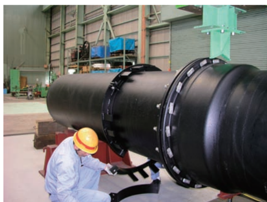
図20 作業員2名によるφ900スラストリング取り付け状況
