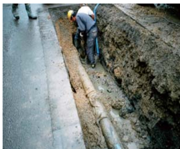
Zn-Al 擬合金溶射+合成樹脂塗装 φ200
