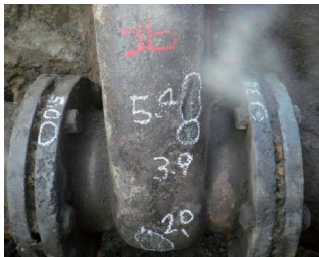
図7 仕切弁掘削・露出調査
