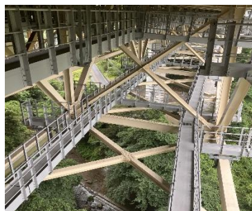
主桁・床版一体型 FRP検査路
